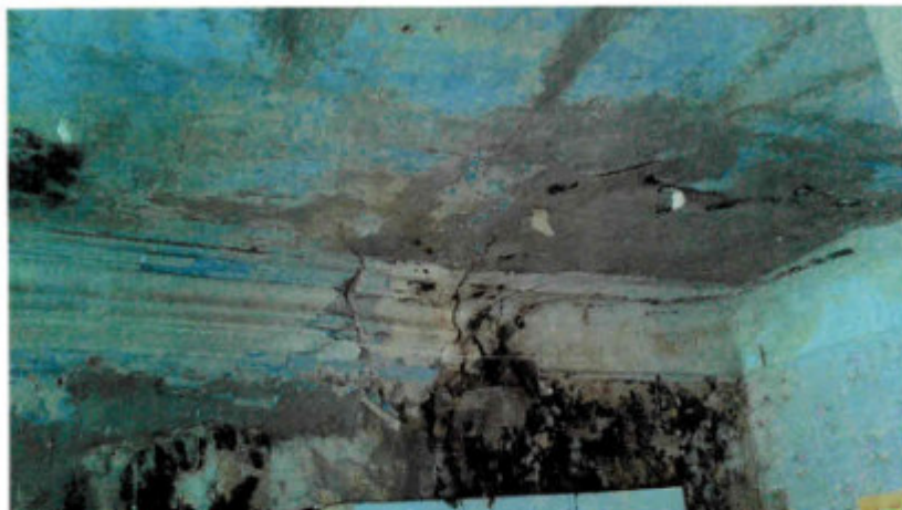
Фото 21. Фрагмент интерьера 2-го этажа. Намокание потолка и стен в следствии протечек, поражение гнилью.
