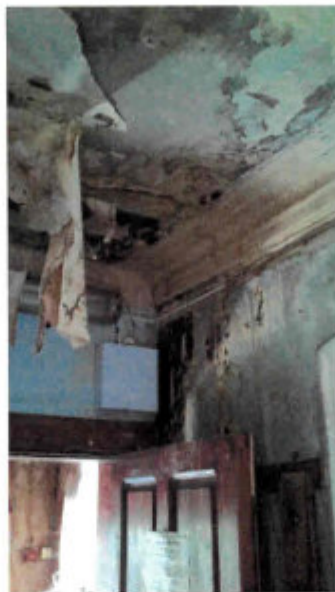
Фото 13. Фрагмент интерьера 2-го этажа. Намокание потолка и стен в следствии протечек, поражение гнилью.
