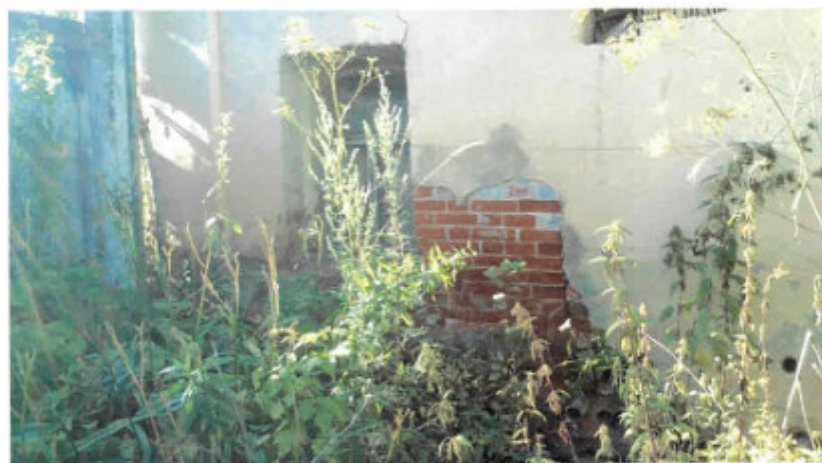
Фото 10. Фрагмент стены. Разрушение штукатурного слоя.
