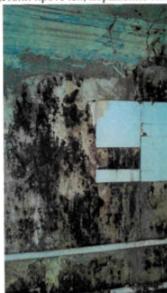
Фото 14. Фрагмент интерьера 2-го этажа. Намокание потолка и стен в следствии протечек, поражение гнилью.
