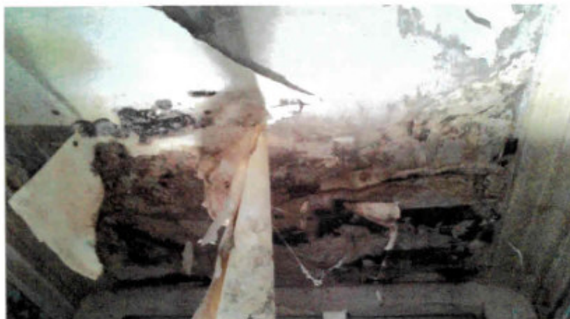
Фото 22. Фрагмент интерьера 2-го этажа. Намокание потолка и стен в следствии протечек, поражение гнилью.
