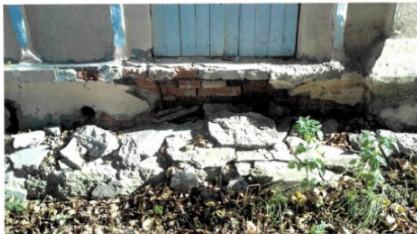
Фото 7. Фрагмент цоколя. Разрушение штукатурного слоя.
